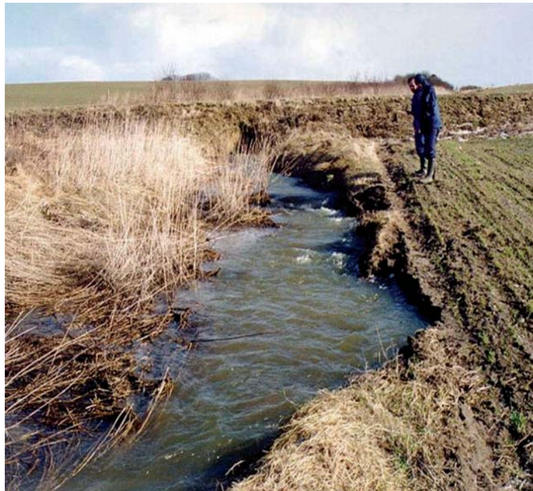
Brinkerrosion er en vigtig kilde til sediment og fosfor i overfladevand.
