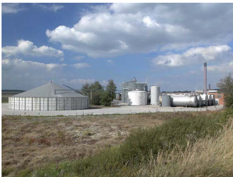
Vegger biogasanlæg i Himmerland (12 km syd for Nibe). Foto: Torben Skøtt.
